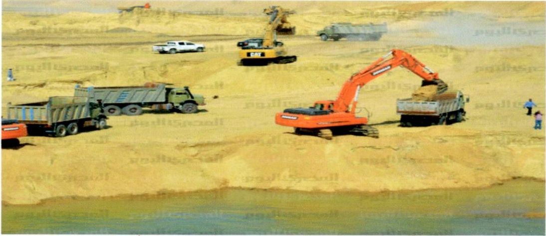
استمرار أعمال الحفر والتكريك بقناة السويس الجديدة تصوير : أحمد شاكر
